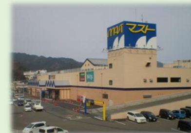
復旧後の外観
